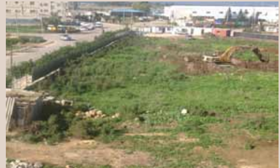
البدء في عمليات الحفر
