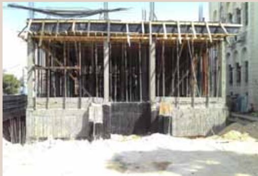
المبنى الجديد في مرحلة البناء
